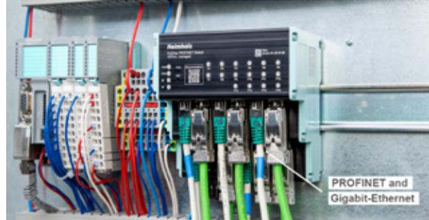
práctico con la disposición inteligente de las tomas Ethernet ahorra espacio en el armario de control. Los LED de estado siempre claramente visibles en la parte superior del FLEXtra Profinet-Switch permiten un diagnóstico sencillo incluso con cableado completo.
