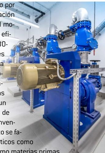
Los motores KSB SuPremE de velocidad nominal de 3.000 rpm de eficiencia clase IE5 están disponibles hasta una potencia de 18,5 kW. Los de velocidad nominal de 1.500 rpm y potencias de hasta 15 kW, cumplen sobradamente con los requisitos IE5 y dispondrán de esta clasificación para finales de 2017. El motor está diseñado sin jaula de ardilla. Las líneas de campo magnético son guiadas por laminaciones especiales del rotor.
