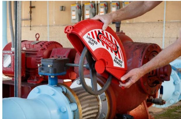
Brady ha desarrollado una solución duradera para bloquear de forma segura las válvulas de volante de 76 a 457 mm de diámetro. Este sistema de bloqueo de válvulas de volante plegable también presenta un sistema de triple plegado para facilitar su almacenamiento.
