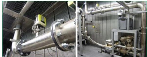
EWZ 150 está compuesto por un tubo Venturi clásico como medidor de volumen, un transmisor de presión diferencial de alta resolución y un calculador de caudal y energía. Según el producto a medir el aparato se instalará colgado (para agua y otros líquidos y vapor) o de pie para gases. Con temperaturas altas (>250°) la técnica de conversión se monta separado del tubo Venturi.
