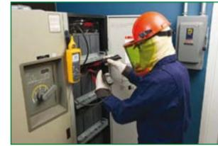
visualización de los resultados de las mediciones en el display LCD auxiliar integrado en la propia sonda eliminando así la necesidad por parte de los técnicos de detenerse y mirar la pantalla principal del instrumento. Los técnicos pueden capturar lecturas de tensiones
