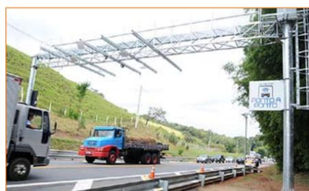
"Point-to-Point" (punto a punto), el primer sistema de peaje del país que cobra por los kilómetros realmente recorridos. Este proyecto piloto, iniciado en abril, emplea el sensor de medición láser LMS511 de SICK y se ha puesto en práctica en una autopista entre las ciudades de Itatiba y Jundiaí.
