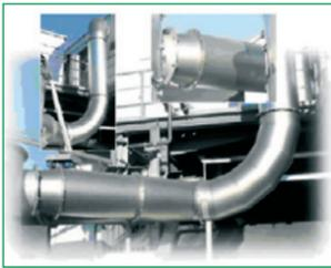
Tecnicork Suárez, S.L. suministra tubería en acero galvanizado, acero pintado e inoxidable. El espesor estándar de nuestra tubería está comprendida entre 1 mm a 3mm y en las gamas de inoxidable entre 1 mm a 2mm. Una de las características de su tubería modular es la facilidad de montaje, gracias al sistema de cierre y apertura rápida con abrazaderas Quick Connect® que permite el montaje sin herramientas.
