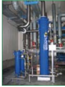
Los separadores LAKOS funcionan por la acción centrífuga que separa las partículas de sólidos por la diferencia de peso específico entre el sólido y el líquido.
