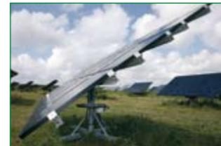
La tecnología de seguimiento inteligente de Solarpark Rodenäs GMBH necesita motorreductores robustos con el fin de colocar y sostener, de manera segura, los módulos frente a los fuertes vientos. La compañía desarrolla sistemas de control manual y totalmente automáticos para el seguimiento del Sol. Estos se accionan por medio de motorreductores compactos y potentes de NORD DRIVESYSTEMS
