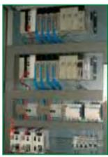
el Standby permanece a la espera, para tomar el control si fuera necesario. En caso de fallo en el automático Primario, el sistema de redundancia realiza una conmutación que transfiere la ejecución del programa de aplicación y el control de las entradas/salidas en el Standby.
