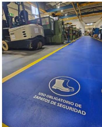
Las losetas de PVC Modulfix permiten cambiar el aspecto de una fábrica, una nave o un taller sin parar la actividad y sin hacer polvo. La unión entre losetas apenas se aprecia, dando la sensación de suelo limpio y continuo. Jugando con los diferentes colores, se puede delimitar espacios de trabajo y de circulación.
